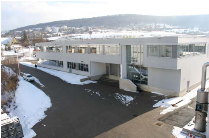
Neubau der Ende 2008 fertig gestellten Kunststoffspritzerei von Schwan-STABILO Cosmetics in Weißenburg
